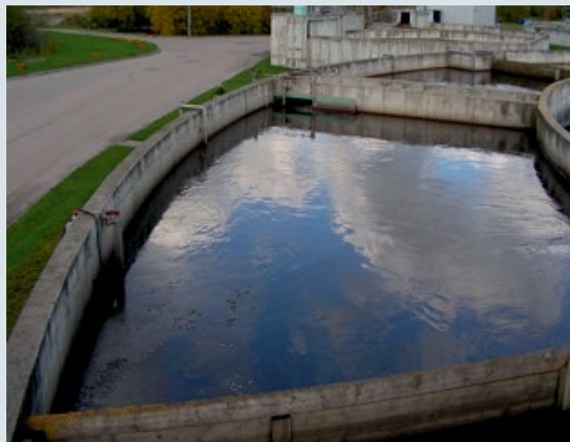
5 pav. Miesto nuotekų valymo įrenginiai prieš ir GREASOLUX naudojimo metu: po kelių mėnesių naudojimo visiškai pasišalino aerotanką dengęs riebalų sluoksnis
