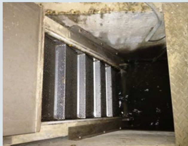
6 pav. Nuotekų priėmimo siurblynė ir grotos prieš GREASOLUX naudojimą ir po jo
