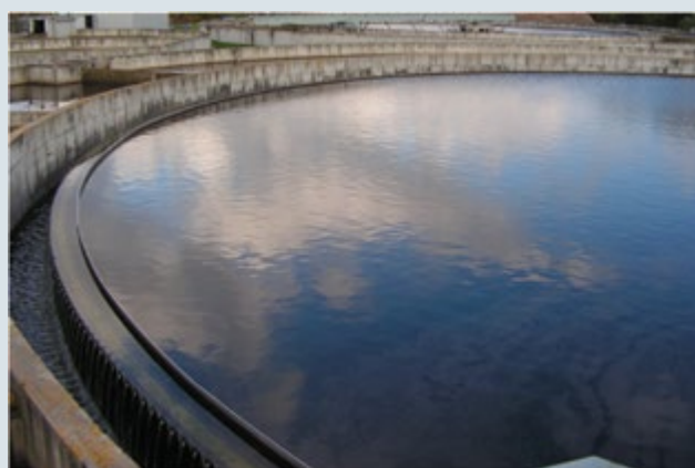
3 pav. Perteklinio dumblo sėsdintuvas miesto nuotekų valykloje prieš ir GREASOLUX preparatų panaudojimo metu.
