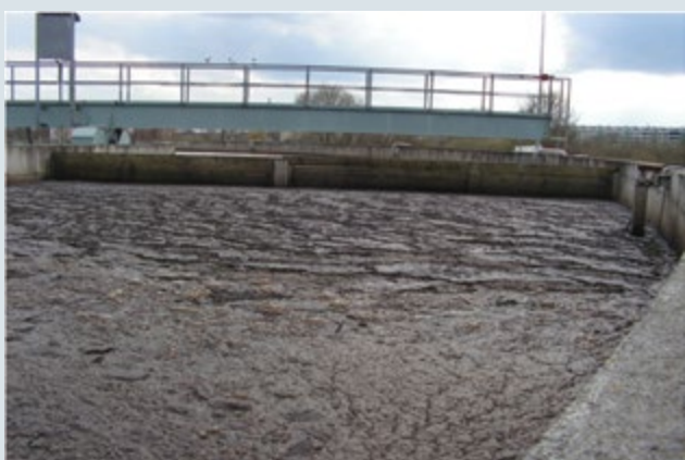
3 pav. Perteklinio dumblo sėsdintuvas miesto nuotekų valykloje prieš ir GREASOLUX preparatų panaudojimo metu.
